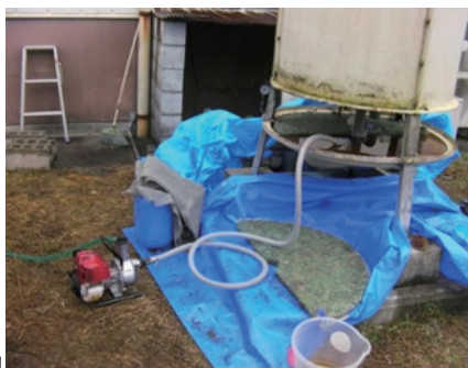
⑤給水ポンプで吸い取っている
